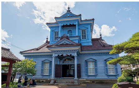
旧鶴岡警察署庁舎(鶴岡)1884 正面に突き出たベランダや上げ下げ窓、洋風の玄関ポーチなど西洋建築の意匠を取り入れた、和洋融合の「擬洋風建築」。
