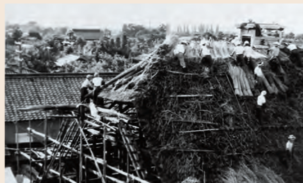
朝日村田麦俣(現鶴岡市)に文政5(1822)年に建てられた多層民家を、昭和40(1965)年に致道博物館内へ移築保存した。
